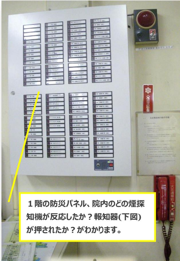
1階の防災パネル、院内のどの煙探知機が反応したか？報知器(下图)が押されたか？がわかります。
